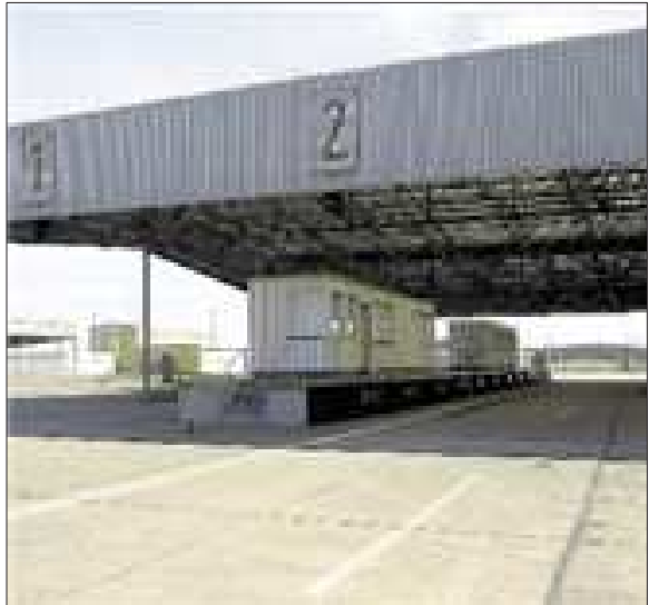
Die ehemalige Grenzübergangsstelle Helmstedt/Marienborn mussten alle Autofahrer passieren, die über die A2 von und nach Berlin fuhrten. Die Gebäude wurden allerdings erst 1974 eingerichtet, fünf Jahre nach der aktenkundigen Autofahrt von Richard Kelber. Heute sind die Gebäude Teil der Gedenkstätte Deutsche Teilung Marienborn.
